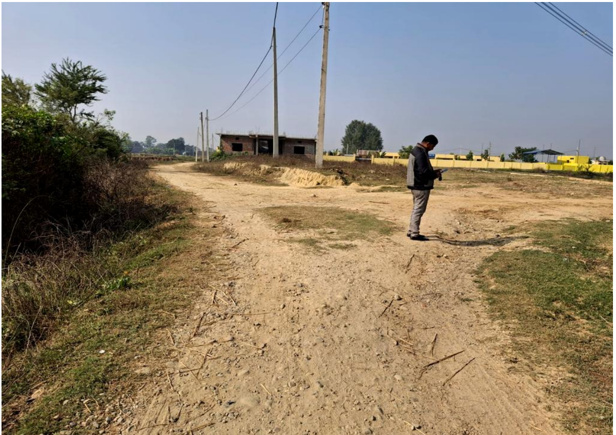
लहान नगरपालिका वडा नं. ९ वडा कार्यालय पछाडीको सडकको अवस्था
